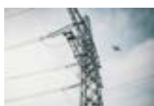
Inspekce vedení vysokého napětí
