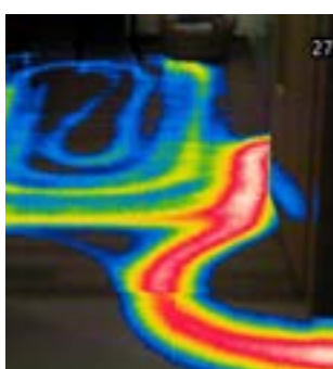
Diagnostika a vyhledávání podlahového topení
