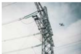
Inspekce vedení vysokého napětí
