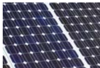
Inspekce solárních kolektorů
