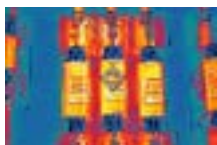
Závada na rozvaděči
