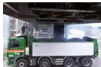
Měření teploty asfaltu
