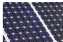
Inspekce solárních kolektorů
