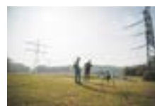
Inspekce vedení vysokého napětí
